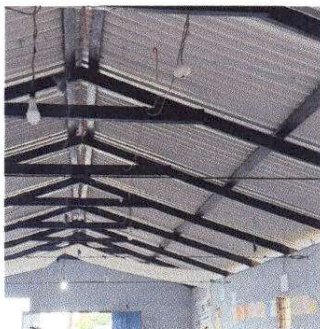
FOTO 7 Instalación de unidades de luz
