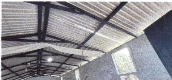
FOTO 1 Sustitución de lámina por lámina troquelada aluzinc cal. 26
