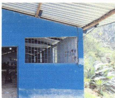
FOTO 3 Sustitución de ventanas de balcón por pvc
