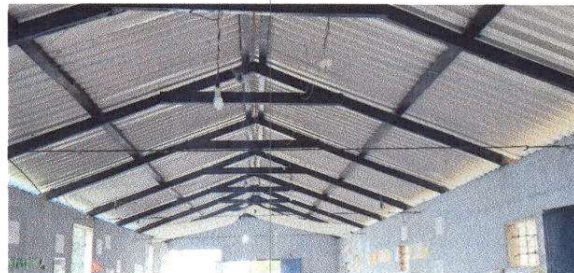
FOTO 2 Sustitución de elementos de fijación
