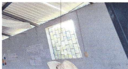
FOTO 8 Instalación de unidades de luz
