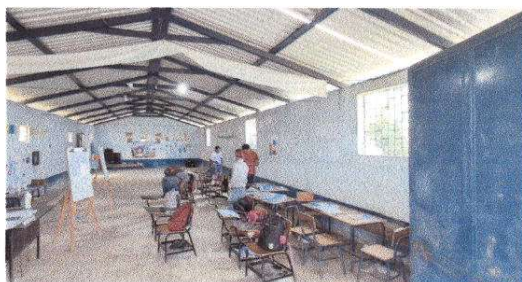
FOTO 5 Sustitución de piso cerámico
