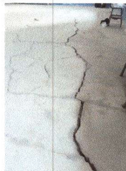
FOTO 4 Reparación de piso de torta de concreto
